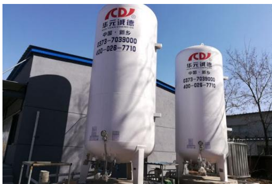
شکل ۷- نمونه‌ای از مخازن بزرگ دوجداره ذخیره اکسیژن مایع
